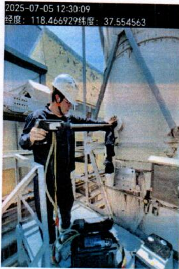
DA002 1.5 万吨 MBS 车间工艺废气净化装置 1#排气筒
