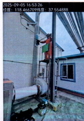
DA015 危废暂存间废 气排气筒
