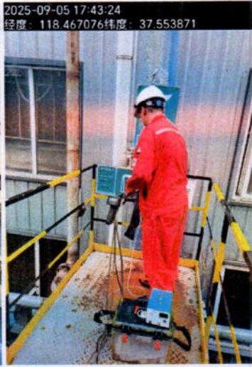
DA003 1.5 万吨 MBS 车间工 艺废气净化装置 2#排气筒
