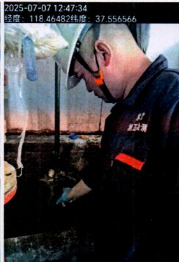
新材料二车间循环水场出口
