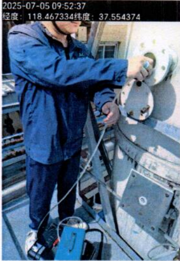
DA002 1.5万吨MBS车间工艺 废气净化装置1#排气筒
