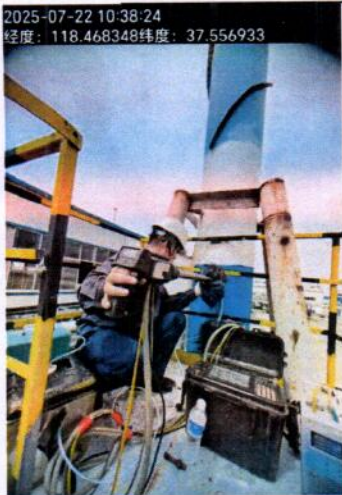
DA008 二胺缩合车间工艺 废气净化装置排气筒
