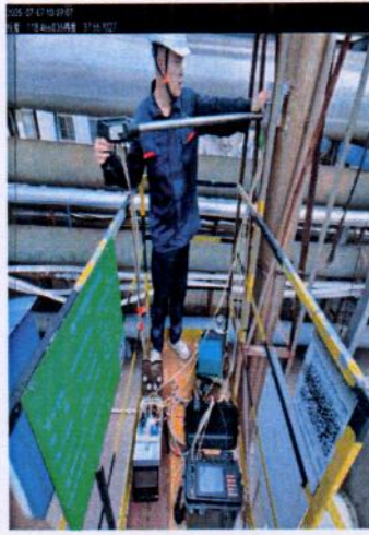
DA013 污水处理站预处理 工段废气治理设施 1#排气筒
