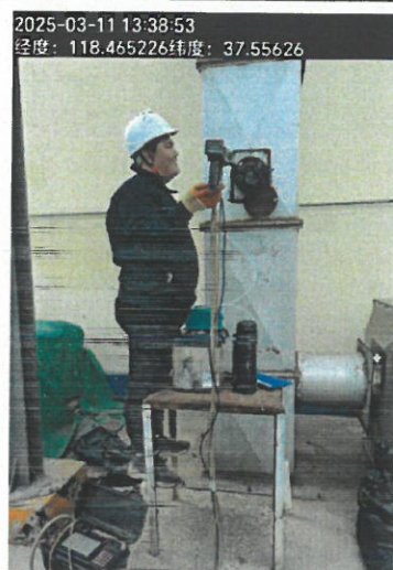
DA015 危废暂存间废气排气筒进口
