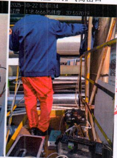
DA013 污水处理站预处理工段 废气治理设施 1#排气筒出口
