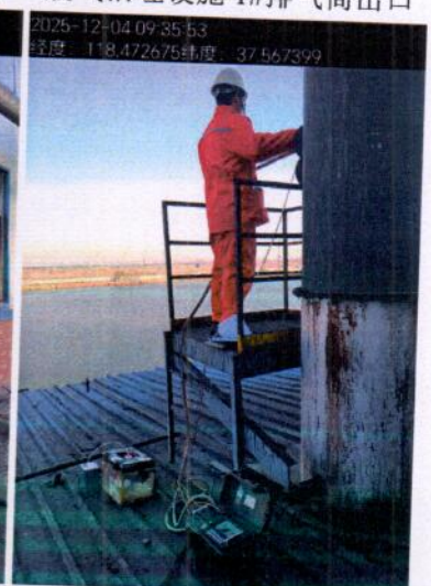
DA009 二胺北厂区工艺废气 净化装置 1#排气筒出口
