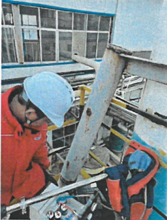
DA008 二胺缩合车间工艺 废气净化装置排气筒
