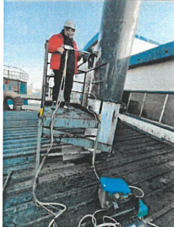
DA009 二胺北厂区工艺废 气净化装置 1#排气筒
