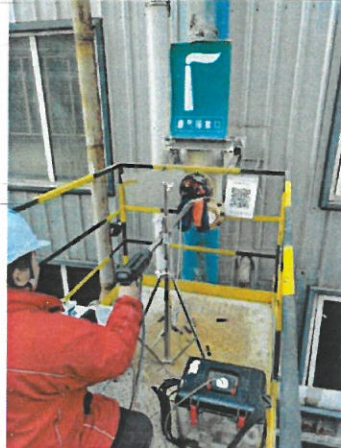
DA003 1.5万吨MBS车间工 艺废气净化装置2#排气筒
