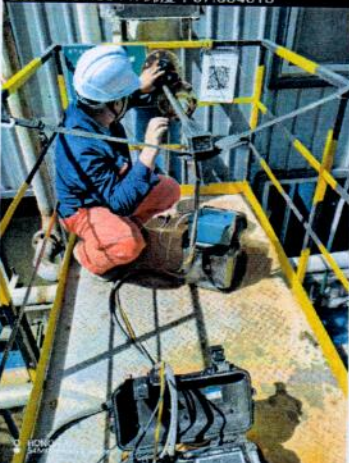
DA003 1.5 万吨 MBS 车间工 艺废气净化装置 2#排气筒
