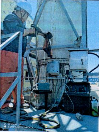
DA002 1.5 万吨 MBS 车间工 艺废气净化装置 1#排气筒
