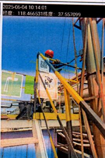
DA013 污水处理站预处理工 段废气治理设施 1#排气筒
