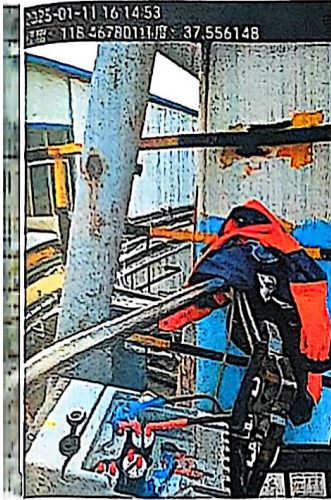
DA008 二胺缩合车间工艺废气净化装置排气筒
