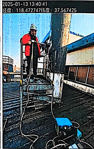
DA009 二胺北厂区工艺废气净化装置 1#排气筒
