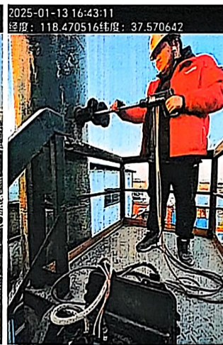
DA026 二胺北厂区导热油炉废气排气筒
