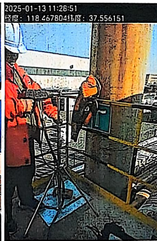
DA025 二胺南厂区导热油炉废气排气筒
